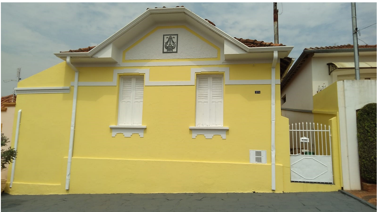
Antes e depois da reforma do Prédio da Corporação Banda Carlos Gomes de Bocaina. PROPONENTE: CORPORACÃO BANDA CARLOS GOMES DE BOCAINA.
